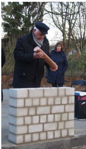
Rolf Beyer legt den Grundstein für die Katenwohnungen. (16.11.2018)
