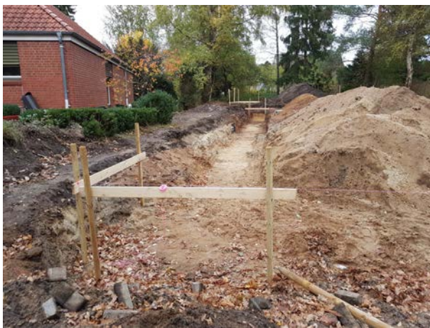
Der Bau hat endlich begonnen. Die Konturen sind zu erkennen... (28.10.2018)
