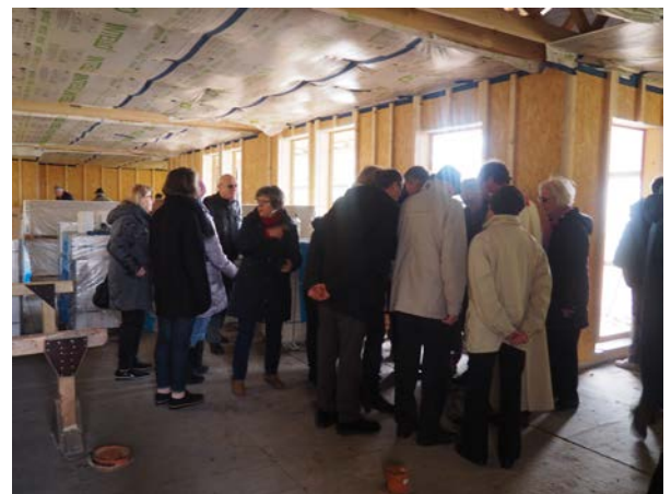
Wände und Dach stehen. Besichtigung durch Spender*innen und Nachbar*innen. (04.03.2019)
