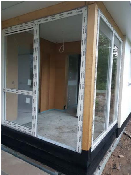
Der gemeinsame Eingangsbereich für je zwei Wohnungen entsteht. (26.06.2019)
