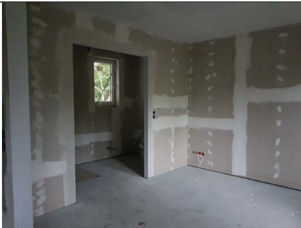
Jetzt werden die Wohnungen und deren einzelne Räume im Trockenbau errichtet. (26.06.2019)
