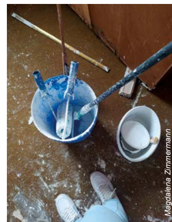
Renovierungsarbeiten im Wohnprojekt
