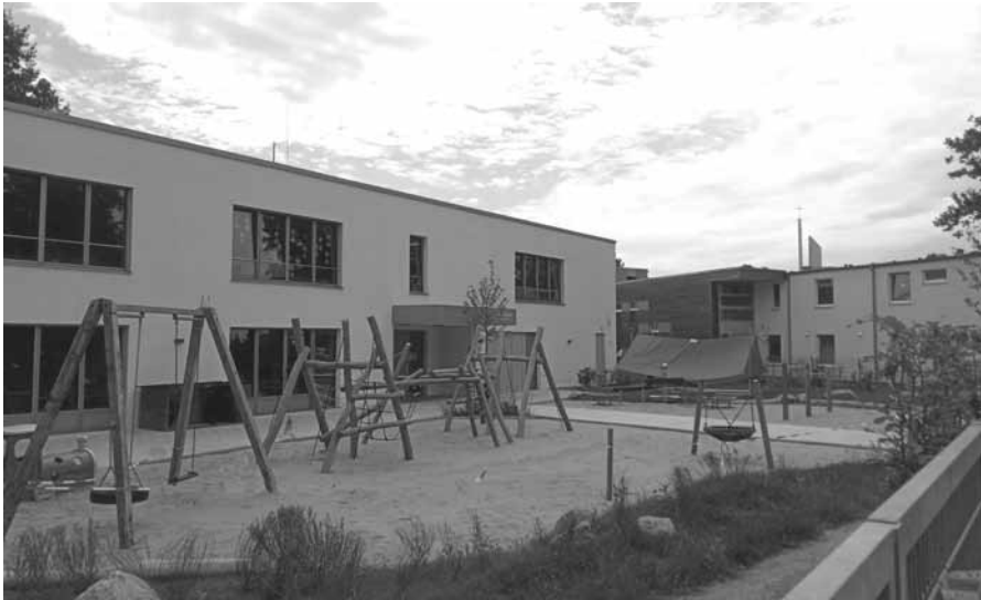
Der neue Kindergarten mit dem Außengelände
