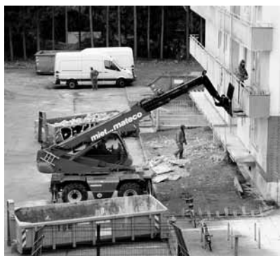
Balkone abgerissen und neu installiert am Hochhaus Friedrichsgaber Weg 433, 2015.
