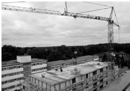
Auf's Dach gestiegen – Handwerker beim Neubau am Röntgengang, 2018.
