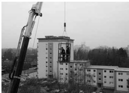
Höhenangst nicht vorgesehen. Blick auf die sanierten Häuser am Friedrichsgaber Weg, 2019.
