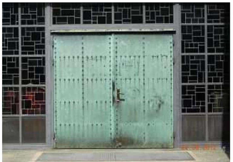
geschützten Türflügel mussten ausgebaut und demontiert werden. Für die zweiwöchige Reparaturzeit wurde eine Ersatztür eingebaut. Was war passiert? Zwischen der Innen- und Außenhaut aus Kupfer befindet sich eine 4cm dicke Holzplatte. Diese saugte das
