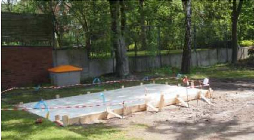
Hier sehen sie unsere Lösung. Es wurde eine neue Garage gefunden, die aber erst einmal ein Fundament brauchte. Danach kamen die Einzelteile, die wie bei einem Baukasten zusammen befestigt wurden.
